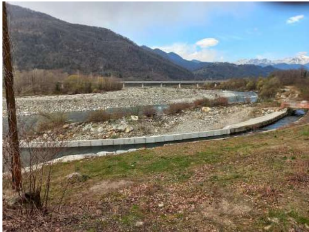
Foto 1 – vista da valle verso monte da sponda dx
