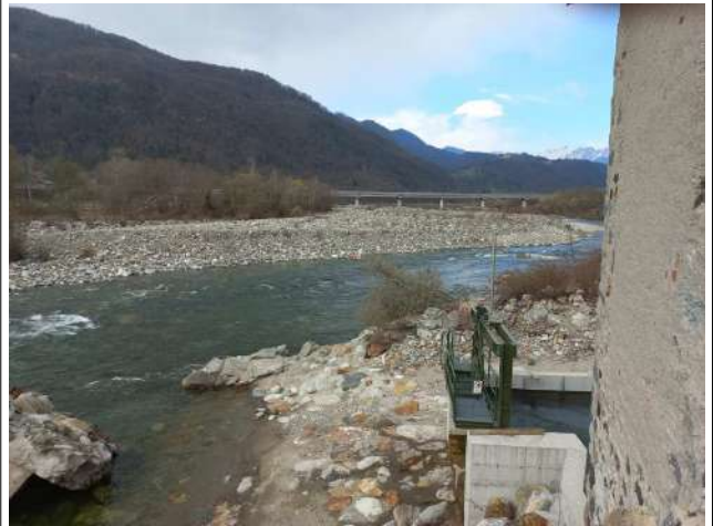
Foto 2 – vista da valle verso monte da sponda dx
