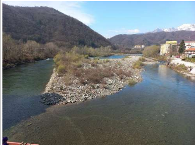
Foto 2 – vista da valle verso monte sponda sx
