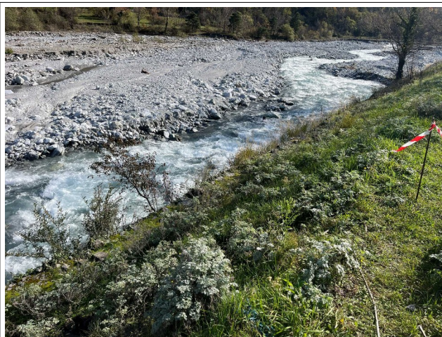
Vista dalla sponda destra
