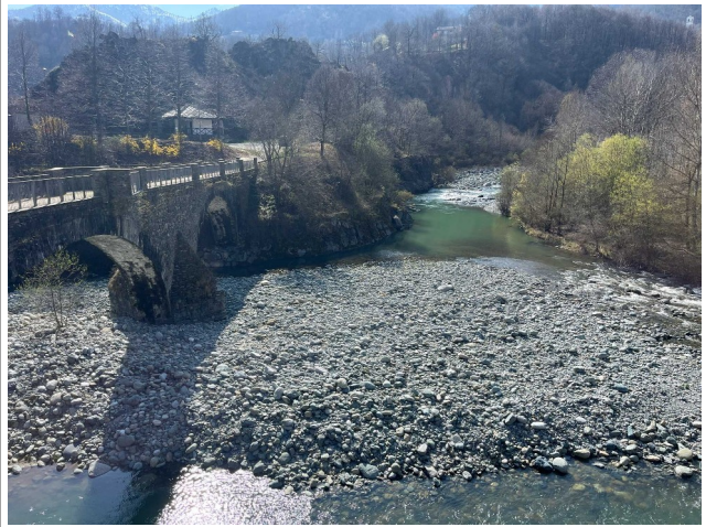
Vista dalla sponda sinistra a monte della passerella
