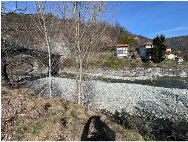
Vista dalla sponda destra a valle del ponte stradale
