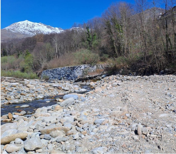
Vista da valle verso monte (sponda sinistra)
